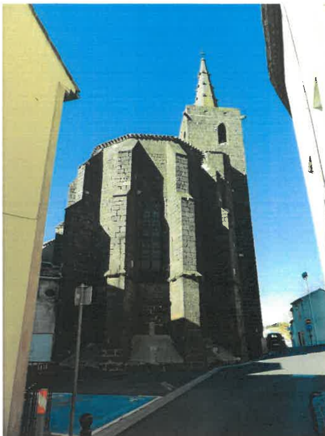
Photo 4 - Vue générale arrière - Forte présence verticale des contreforts de l'abside qui s'imposent, y compris dans les vues plus éloignées.
