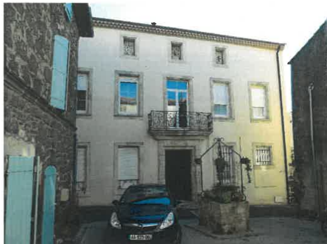
Edifices et espaces publics associés.
